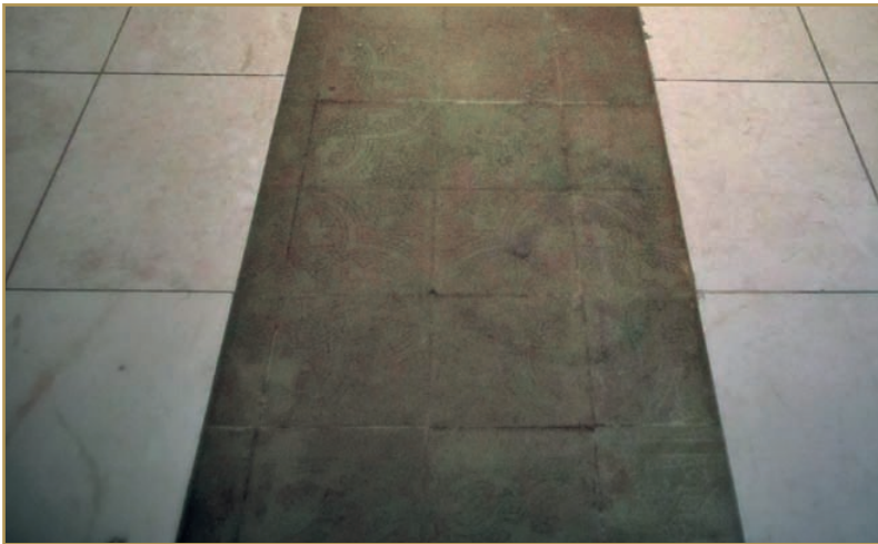
İç mekanda bazı düzenlemelere gidilen binada zemin ortasında açık bırakılan kısım binanın ilk yapımında kalan zemin karoları
