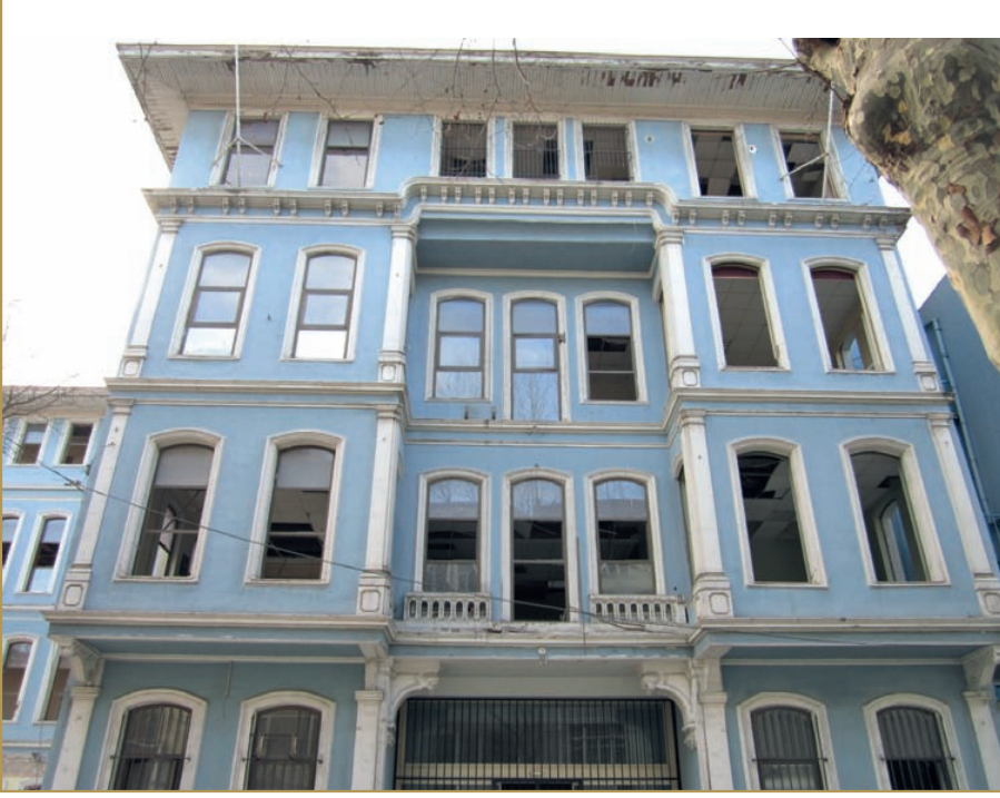
Konağın Doğu Cephesindeki Girişi
