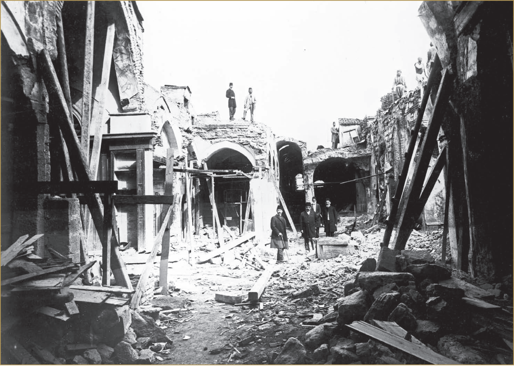
1894 İstanbul Depreminde Büyük Hasar Gören Kapalı Çarşıdaki Dükkanların Durumu (IRCICA Arşivi)
