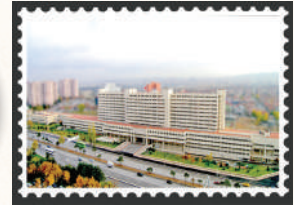
Sayıştay Hizmet Binası (2002- )
