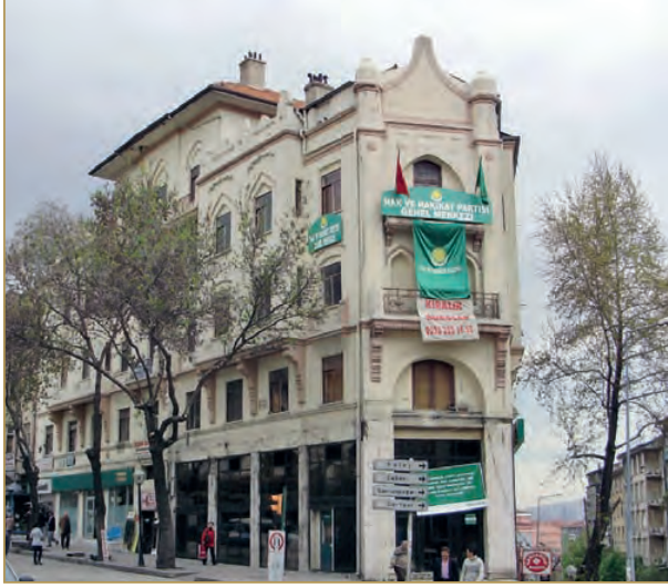
Günümüzde Hasan Fehmi Ataç Apartmanı
