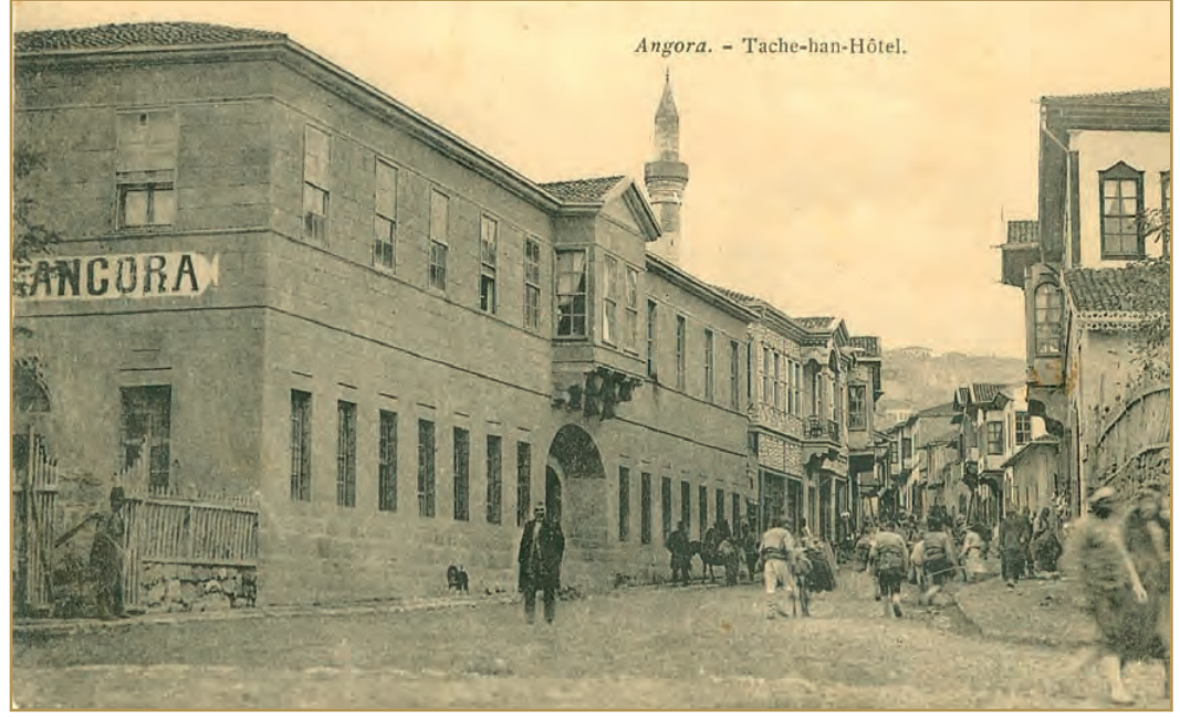
Ancora Levhası Asılı Halde Taşhan XIX. Yy'ın Sonundaki Görünümü (VEKAM Arşivi)
