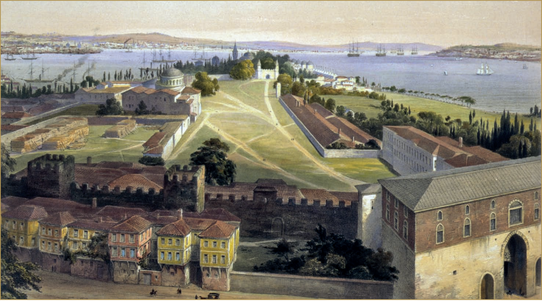
Gaspore Fossatinin Litografya Çizimiyle Topkapı Sarayı 1. Avlunun Görünümü ve Sağ Köşede Avluya Dikey Uzanan Yapı, Maliye Nezareti Binası aynı zamanda Divan-ı Muhasebatın da İlk Kullandığı Bina. (Library of Congress)
