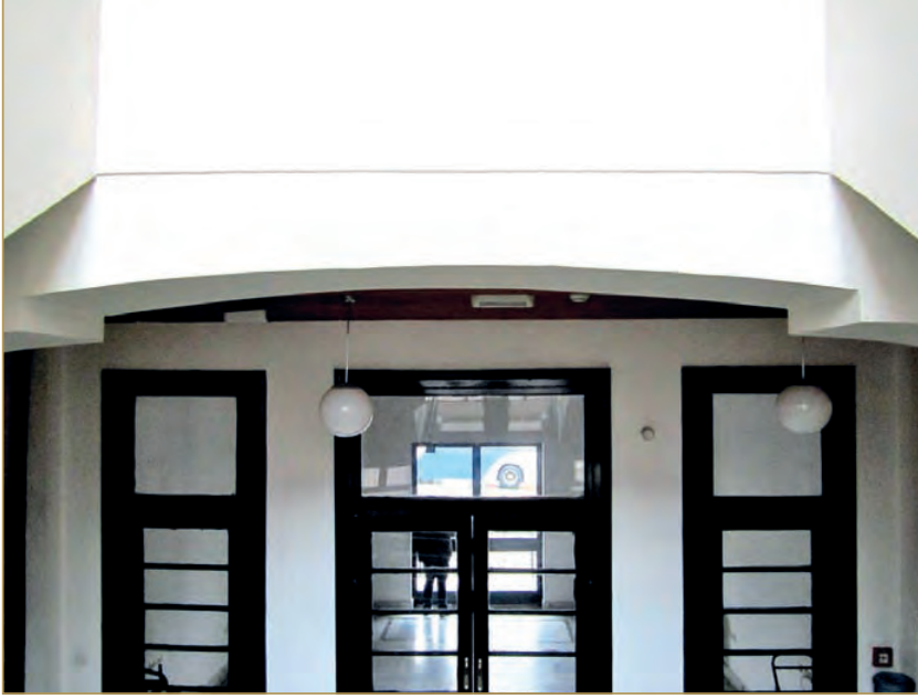
Giriş Katında Bulunan Bursa Kemerli
