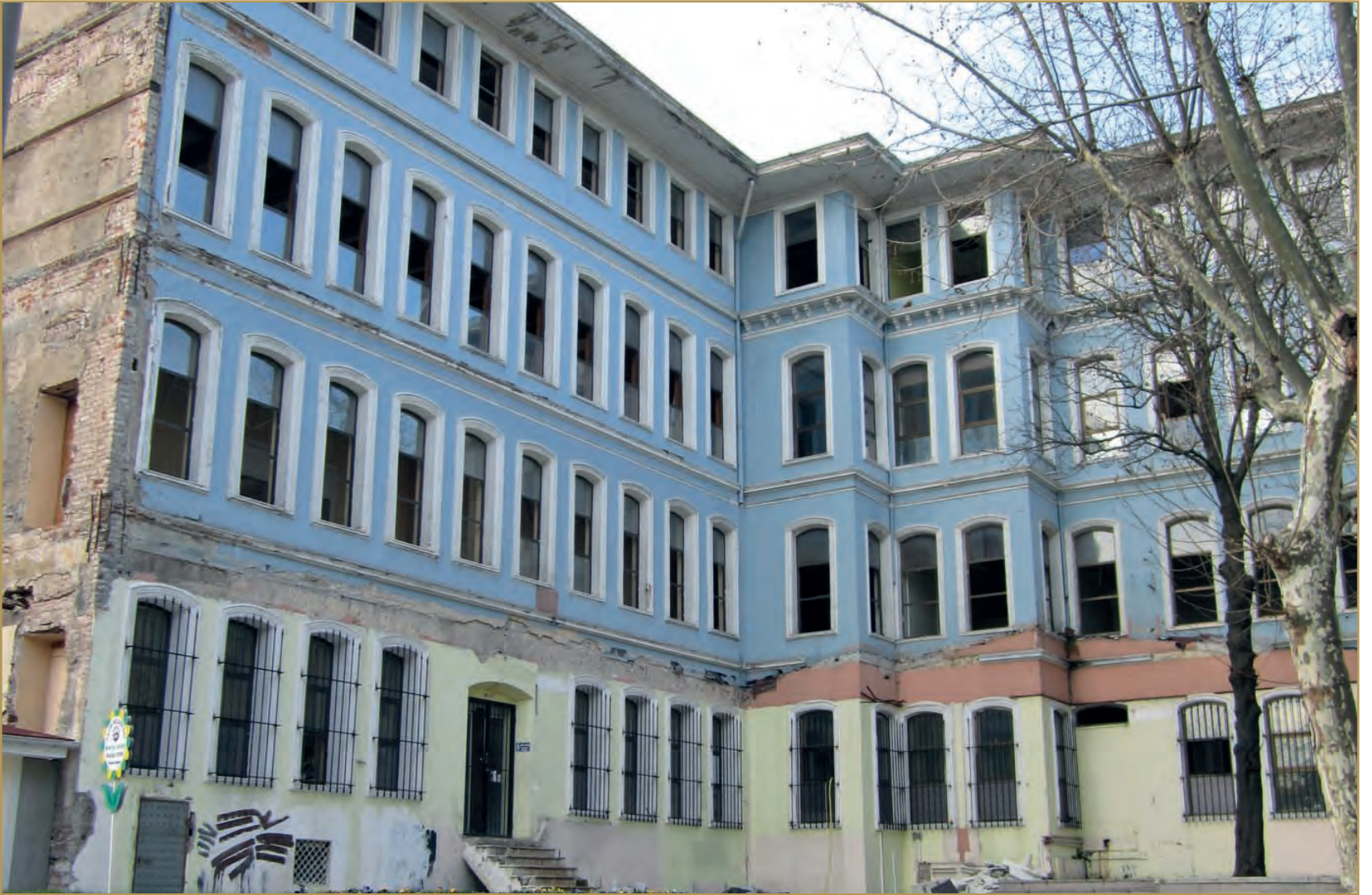
Şerefiye Sarnıcı'nın Üstünde Kalan Ek Yapının yıkılmasından sonra Konağın Görünüşü
